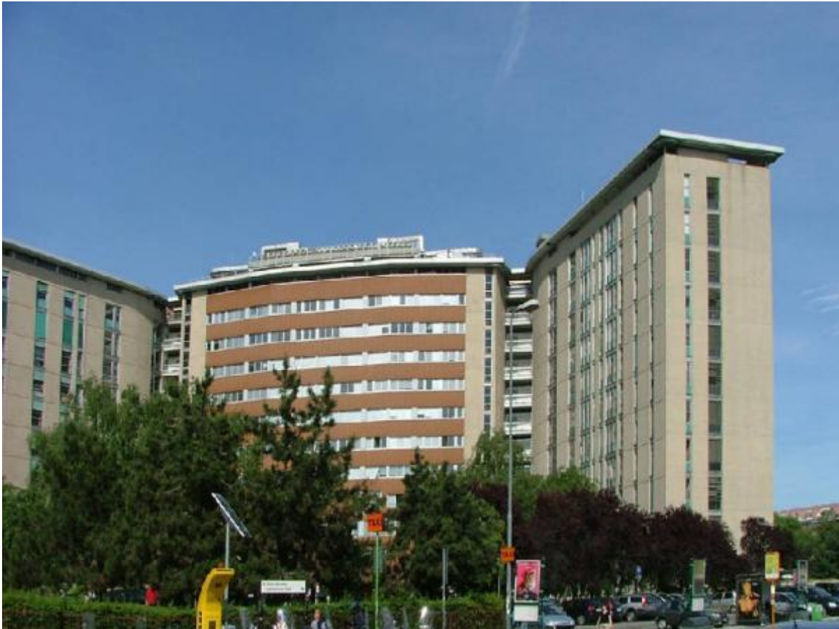
Vista sull'ingresso principale all'ospedale da via A. di Rudinì, 8
