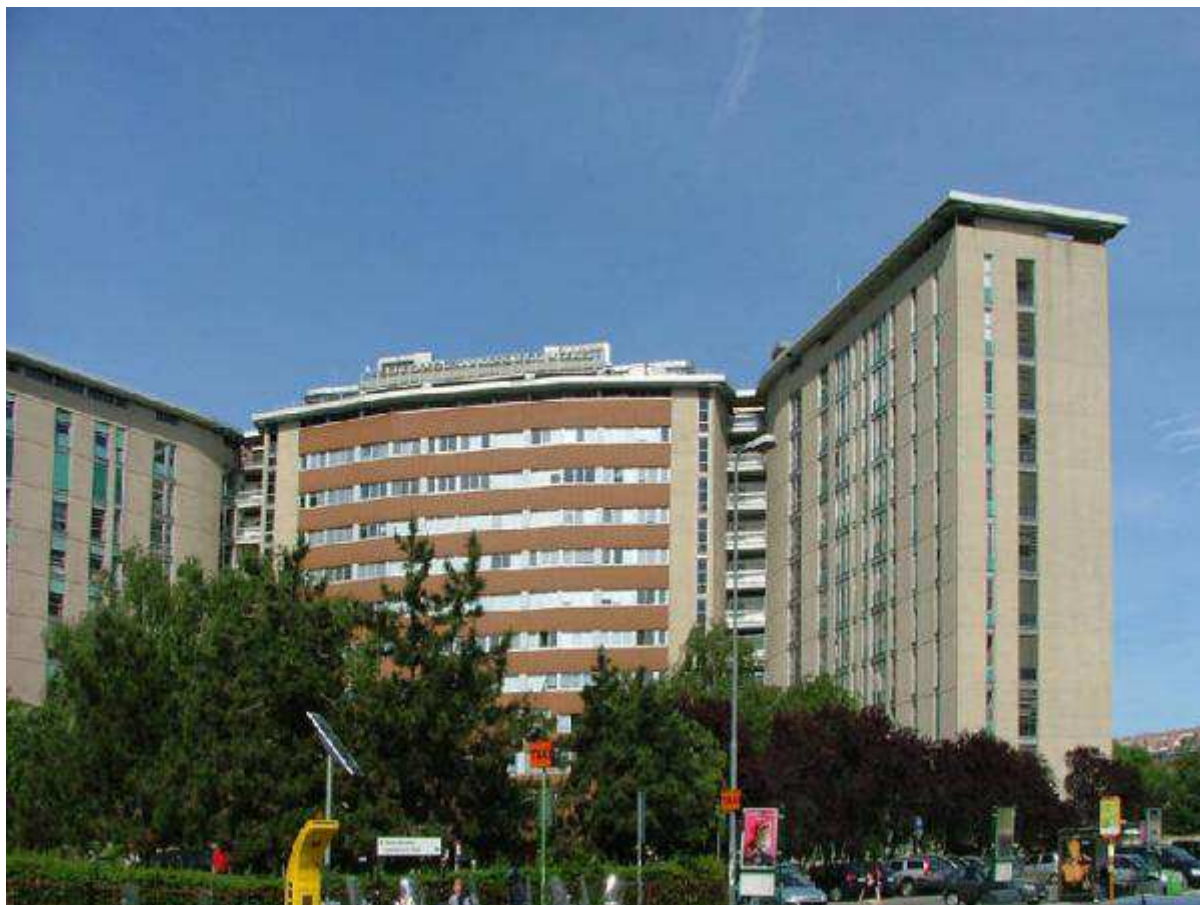
Foto 1 - Vista sull'ingresso principale all'ospedale da via A. di Rudini, 8
